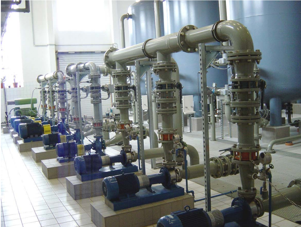
Wasserwerk Dörfeld – modernisiert und erweitert 1995
