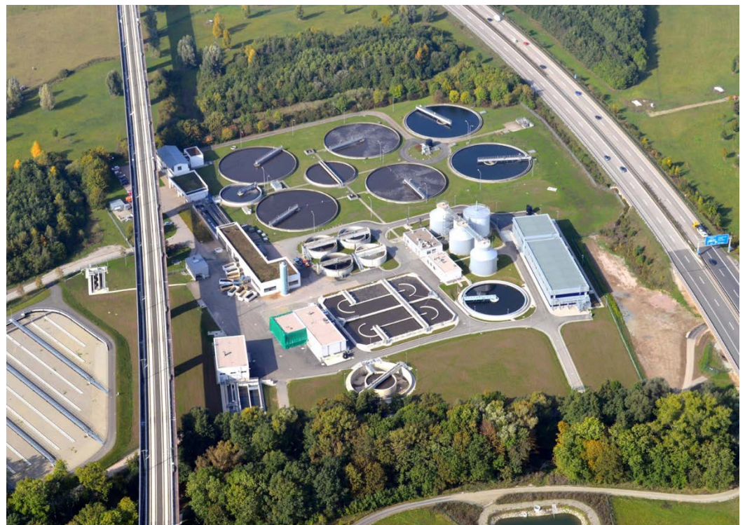
Verbandskläranlage Arnstadt in Ichtershausen - Inbetriebnahme 1995; 1. Erweiterung 2007 und 2. Erweiterung 2015/2016 für das Industriegebiet Erfurter Kreuz
